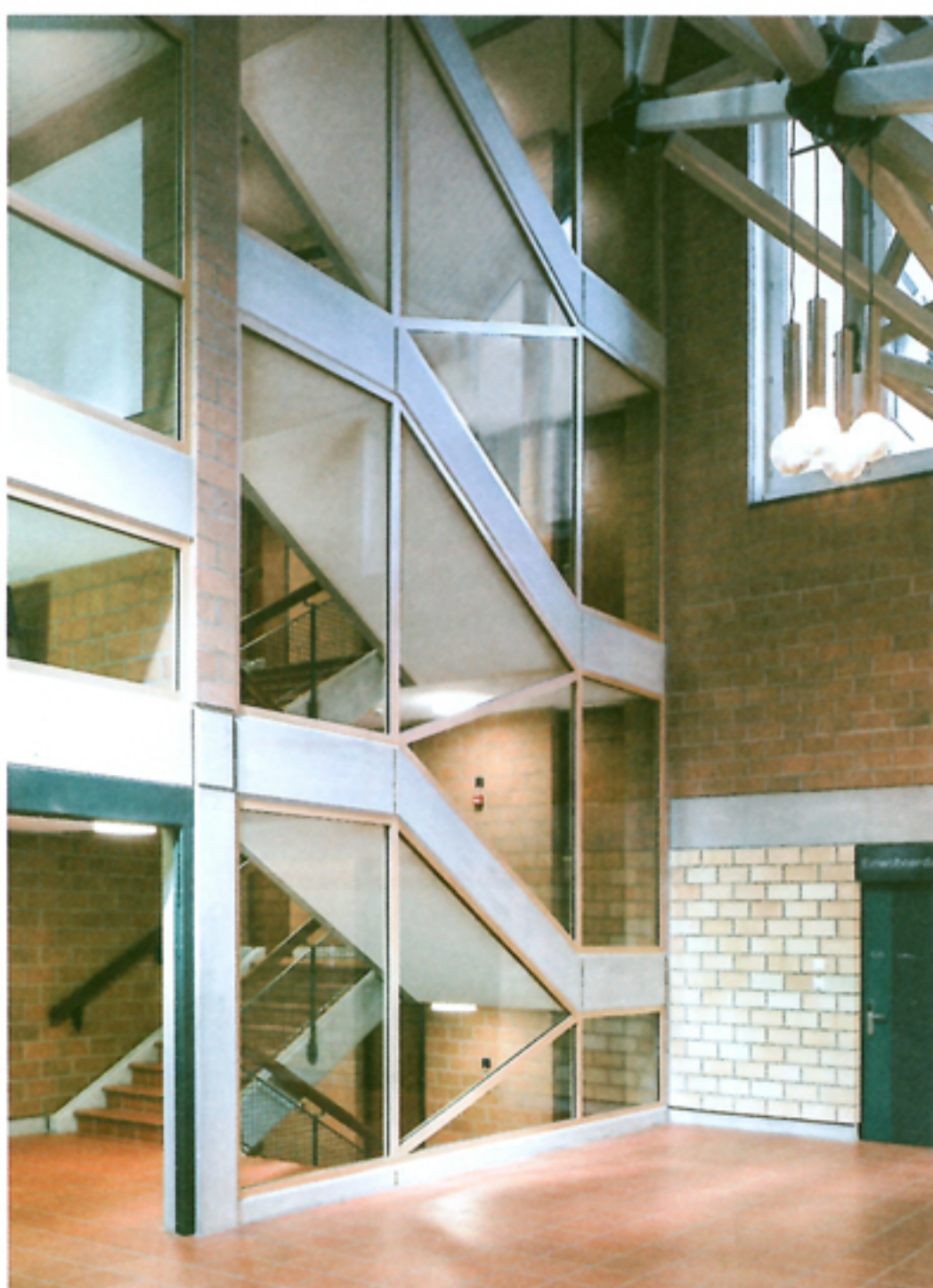
Die Eichenprofile der neuen Verglasung bringen Bewegung ins Treppenhaus. Hinter den Fenstern links befinden sich neue Besprechungsräume.
