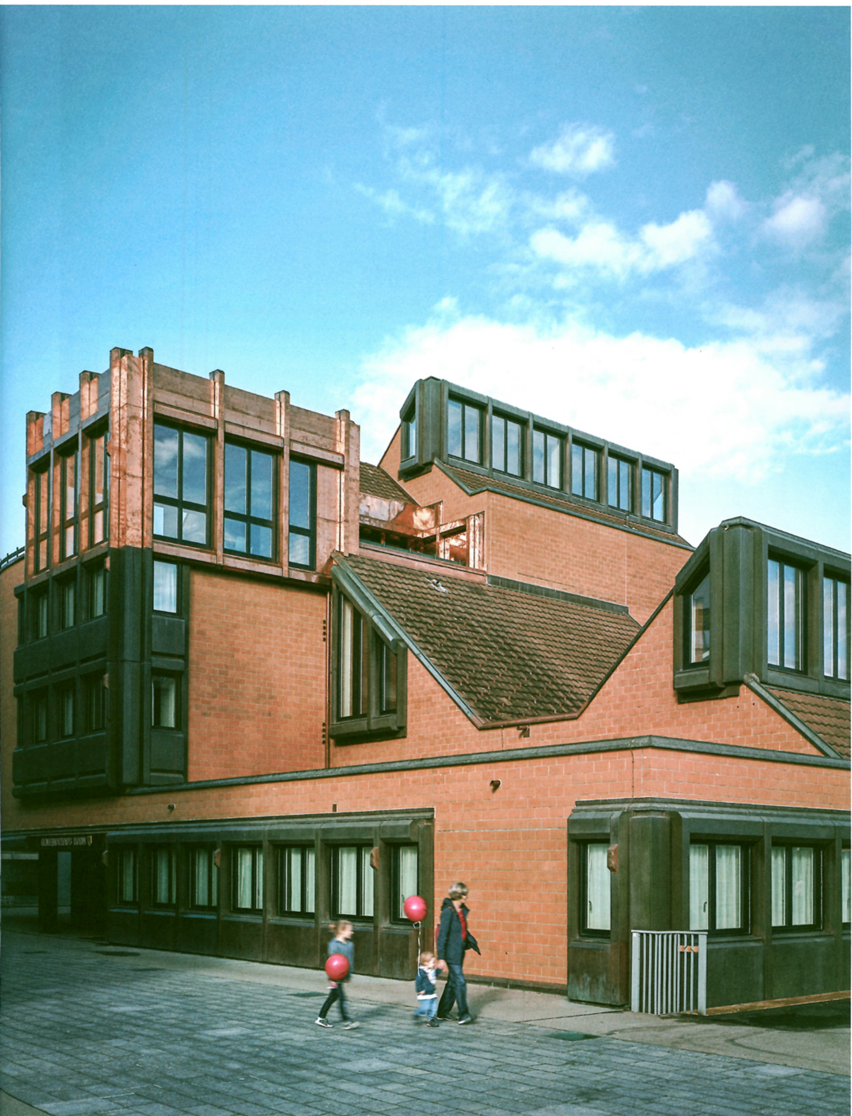
Ein Haus wächst weiter: Gemeindefhaus Horw von 1979, Erweiterungen auf dem Dach von 2016.
